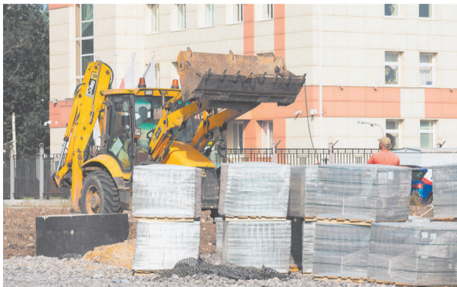
Первыми на объект «зашли» владельцы инженерных сетей. Прокладывали новые трубы и меняли старые
